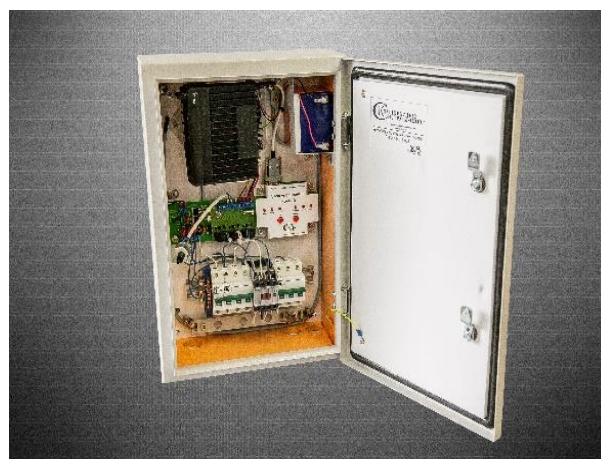
Рис. 10.10 Устройство включения электросирен
